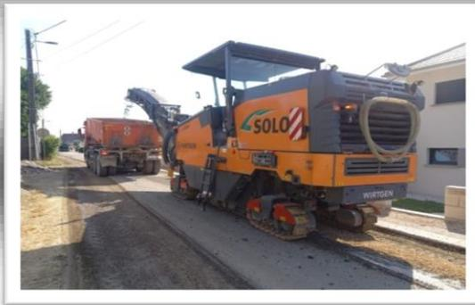
**Route de la forêt de Chaux** : Ces travaux ont été financés à 80% par le **FEADER** (Europe) et à 20% par **GBM** (Grand Besançon Métropole). Des bordures d'écoulement d'eau et les puisards pour infiltration des eaux usées ont été installés. L'entreprise **COLAS** a procédé au rabotage de la route dont les gravats ont permis de remettre en état l'impasse des vignes Lombard. De plus, une nouvelle couche d'asphalte a été posée sur toute la route menant à l'entrée de la forêt de Chaux.
